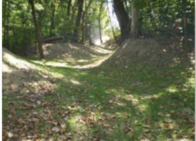
Una vez vegetado, el TRM PS42 no es visible. Sin embargo, continúa proporcionando un control de erosión significativo y permanente reforzando la vegetación.
